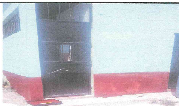
Foto 4: Sustitución de puertas
