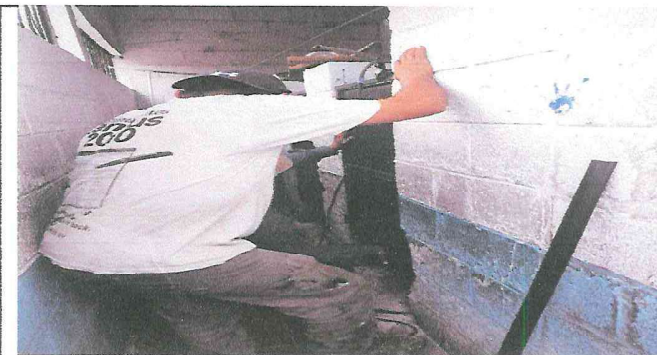
Foto 3: Sustitución de puerta
