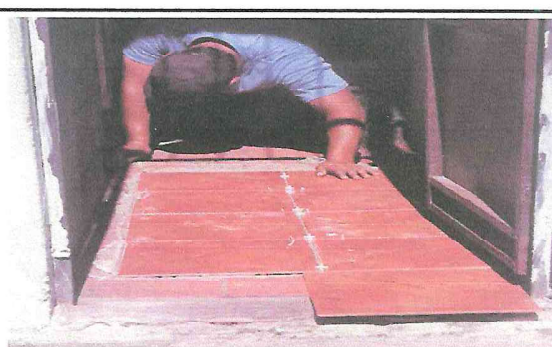
Foto 6: cambio de piso
