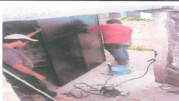
Foto 2: Sustitución de puertas
